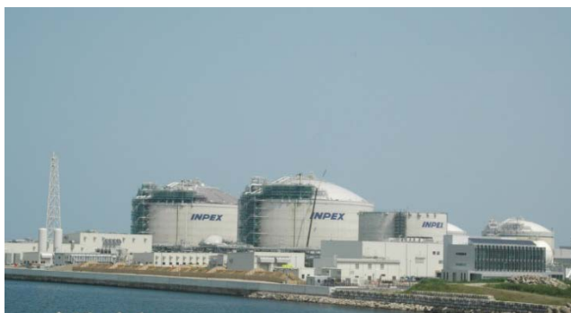
直江津 LNG 基地
