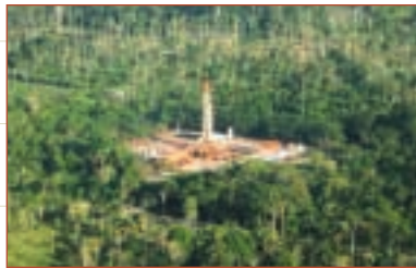
エクアドル試掘現場
