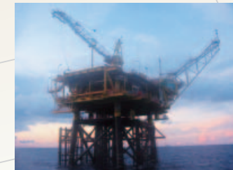
ジンタン・ガス田海洋生産施設
