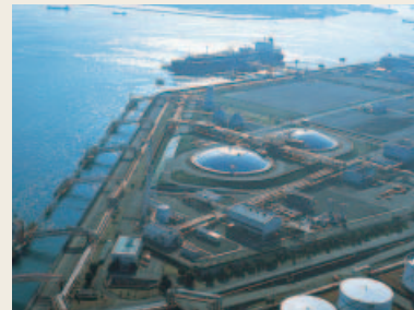
LNG受入基地
