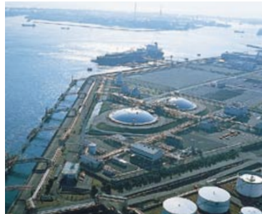
清水LNG袖師基地
