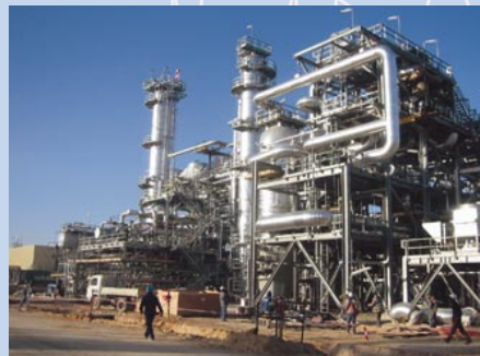
ガス処理プラント
