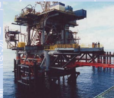
ヘラン海洋施設
