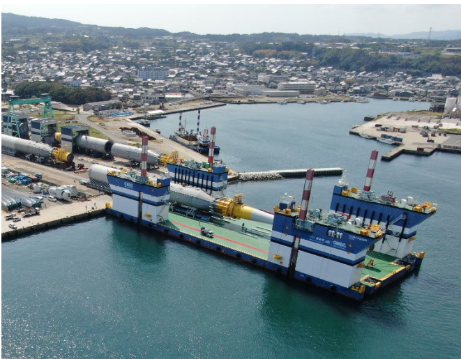
浮体積み込み状況
