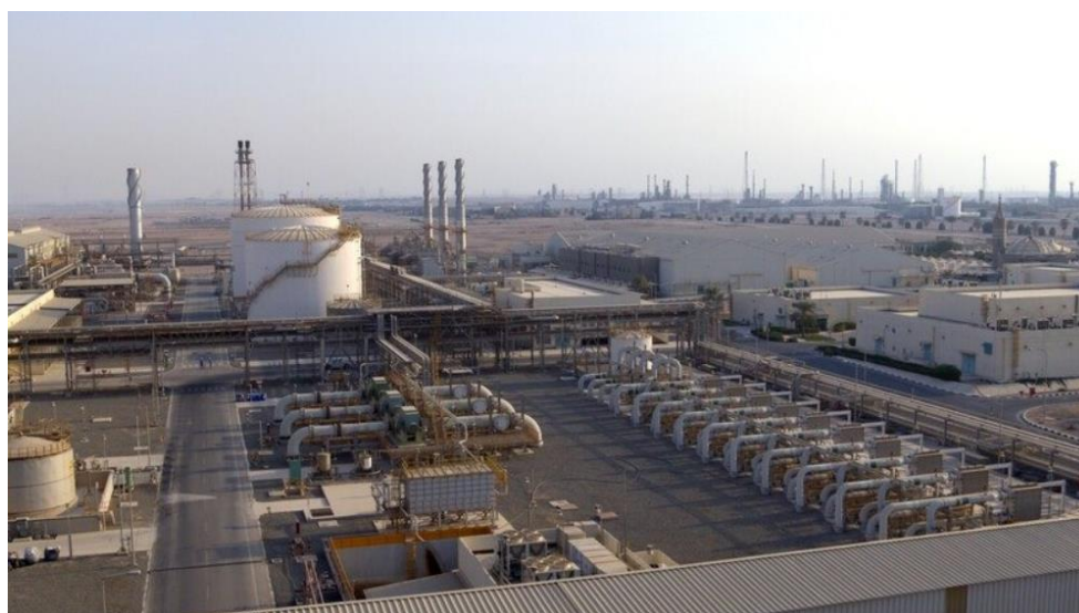
アブダビにおけるアンモニア生産プラント
