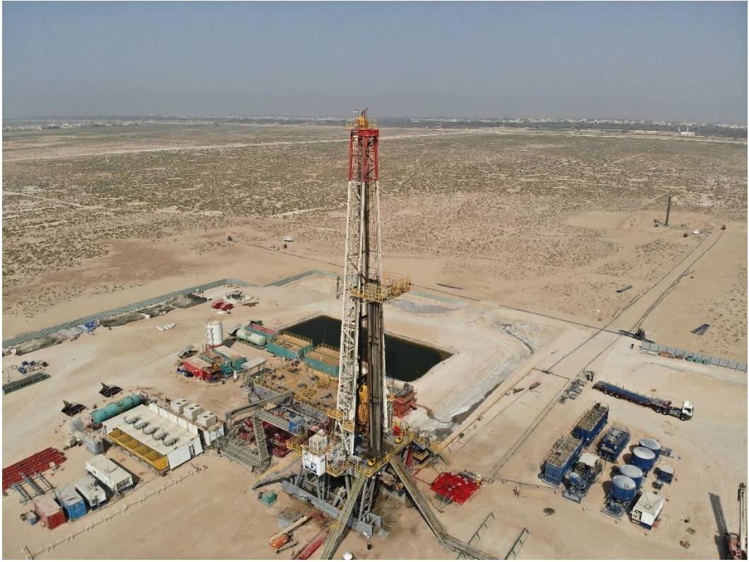
本坑井における掘削作業の様子
