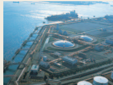
LNG受入基地
