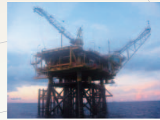
ジンタン・ガス田海洋生産施設
