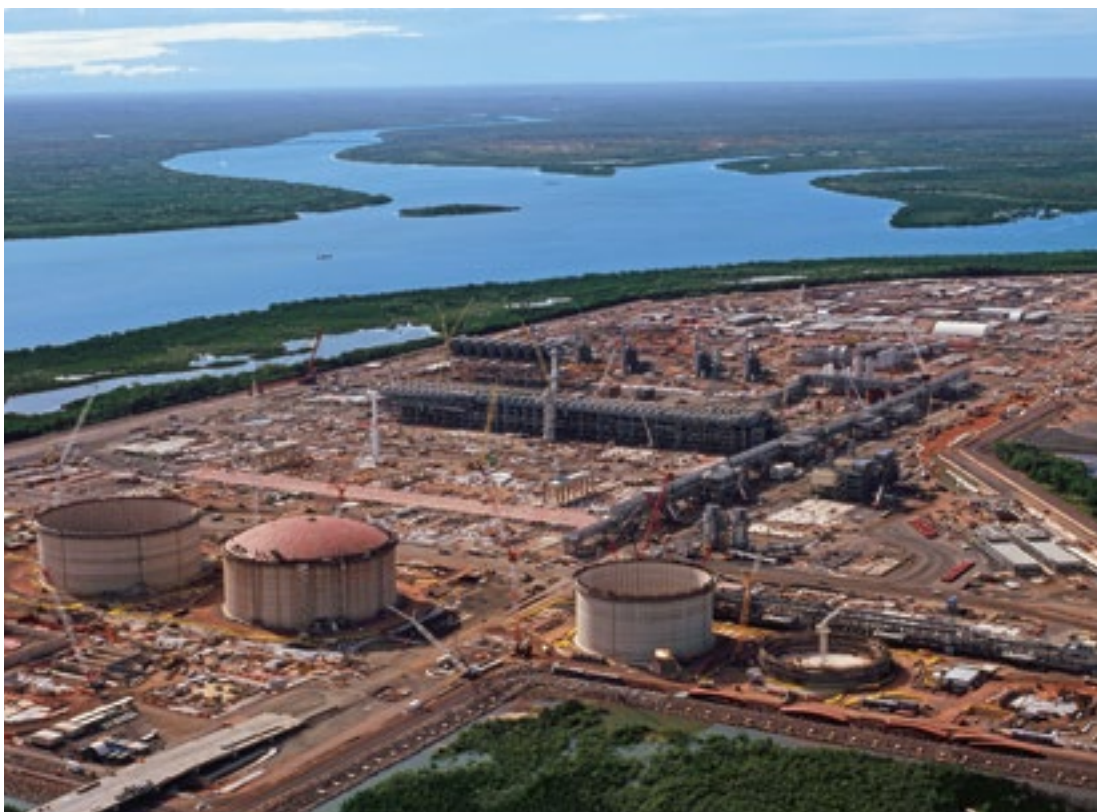
建設が進む陸上ガス液化プラント
