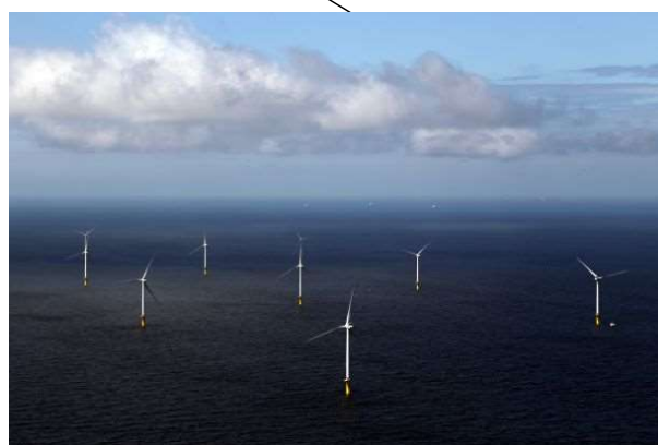
Luchterduinen offshore wind farm
