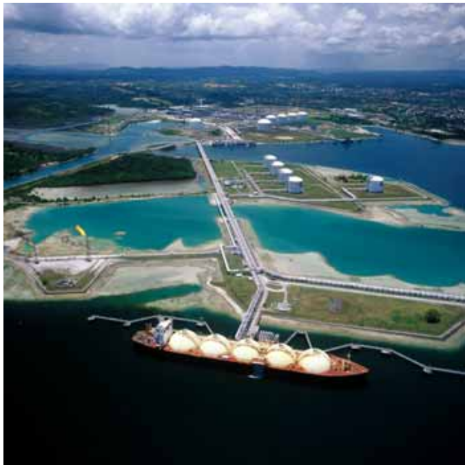
Bontang LNG Plant
