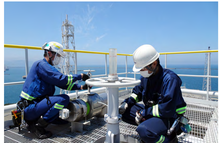
フェイスシールドとマスクを着用しての作業の様子(直江津LNG基地)
