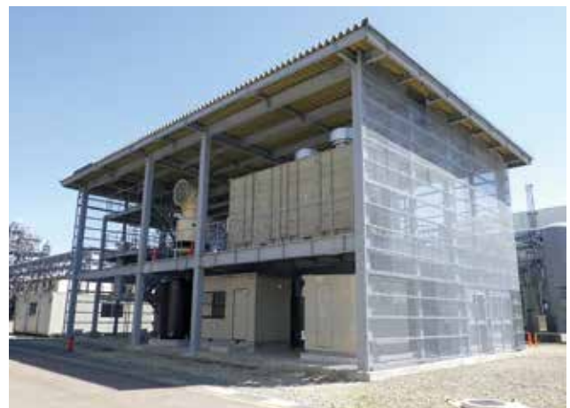
建設中のCO 2 メタネーション試験設備
