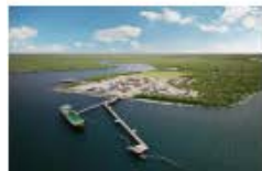
出荷棧橋建設完了
