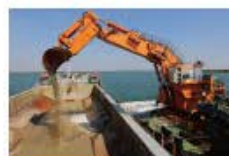
浚渫作業開始
