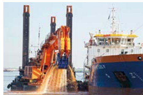
浚渫作業の様子
