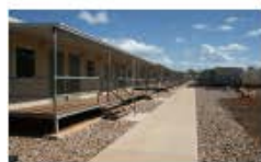
建設作業員宿泊施設操業開始
