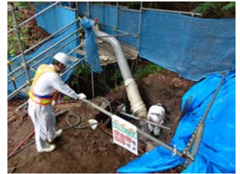
東京ラインの健全性調査工事現場
