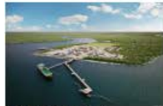
出荷棧橋建設完了
