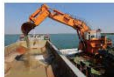
浚渫作業開始
