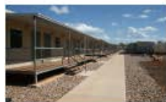
建設作業員宿泊施設操業開始
