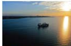
浚渫作業完了
