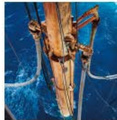
生産井掘削開始
