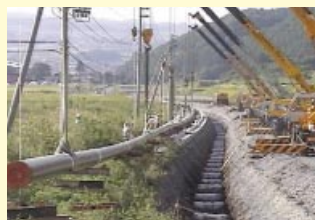
松本ライン建設工事
