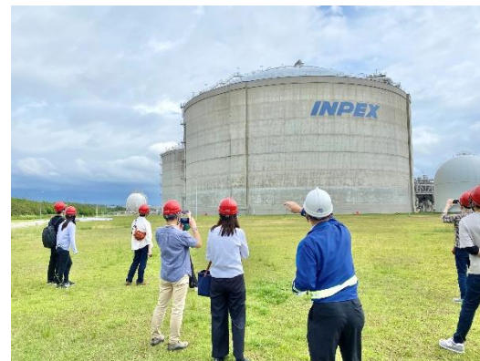
LNGタンクのご見学 写真撮影
