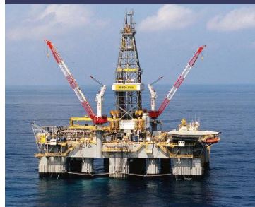
井戸の掘削機
