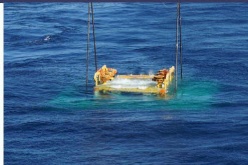
生産装置の海底面への設置作業
