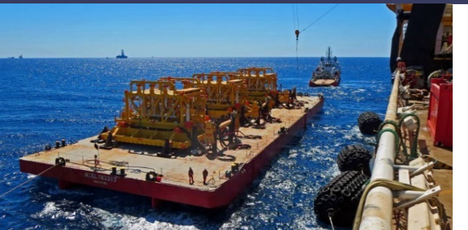
生産装置の海底面への設置作業
