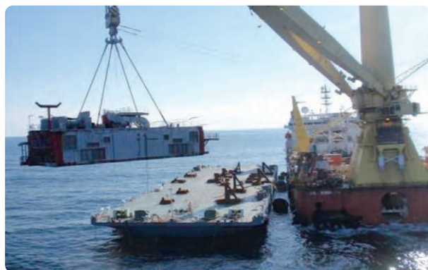
プラットフォーム上載設備撤去の様子
