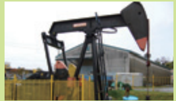
八橋油田ポンピングユニット
