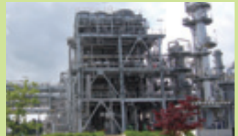
越路原プラントガス処理施設
