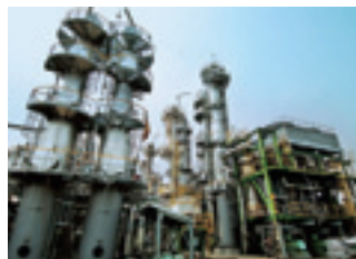
新潟県越路原プラントガス処理施設
