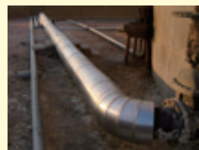
アスベスト除去後のライン
