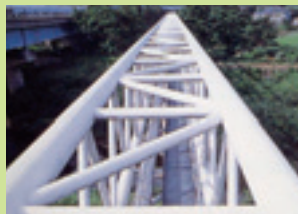
帝石パイプライン トラス橋
