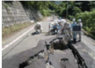
パイプライン埋設道路の被災状況調査
