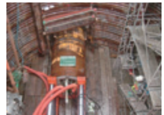
ガスパイプライン工事
