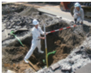
ライフライン(ガス管)被災状況確認調査の立ち会い
