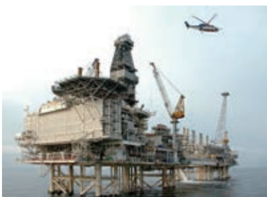
海上生産施設
