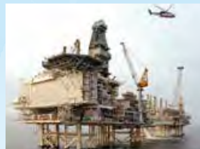
海上生産施設
