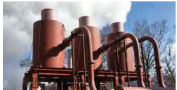
秋田県小安地域における仮噴気試験
