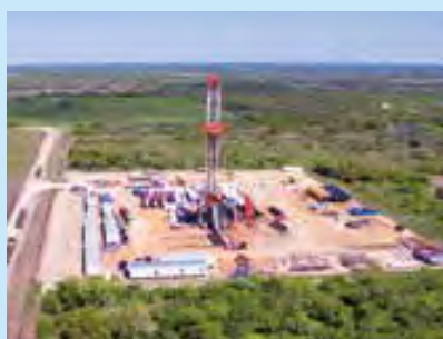
掘削作業現場
