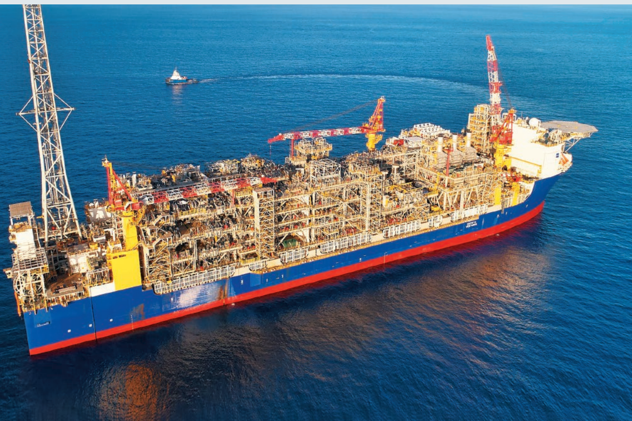
イクシスLNGプロジェクト FPSO「イクシス ベンチャー」
