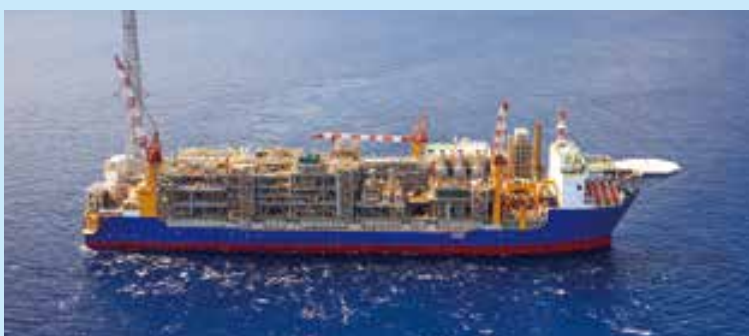
FPSO「イクシス ベンチャラー」
