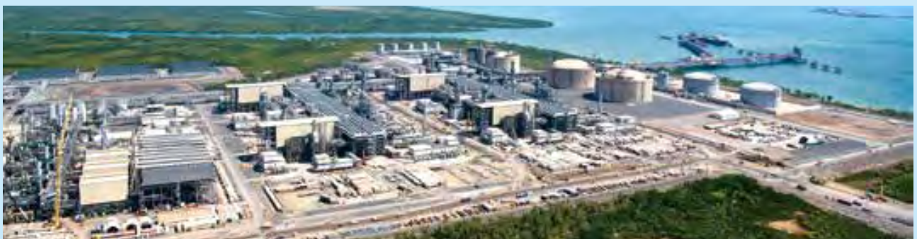
陸上ガス液化プラント
