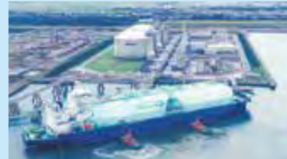
直江津LNG基地
