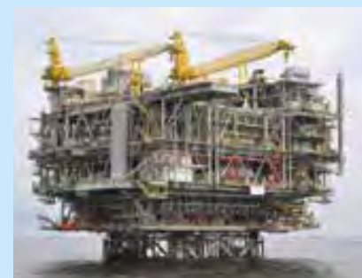
海上生産施設
