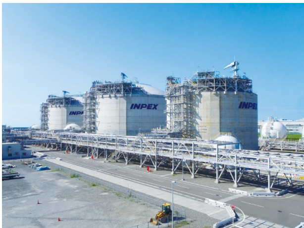
Naoetsu LNG Terminal
