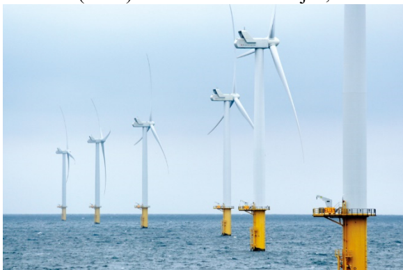
Luchterduinen Offshore Wind Farm
