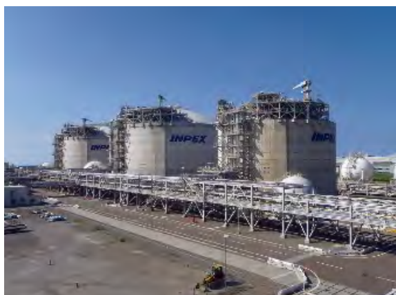
Naoetsu LNG Terminal
