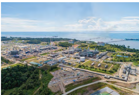
LNG liquefaction plant, Tangguh LNG Project
