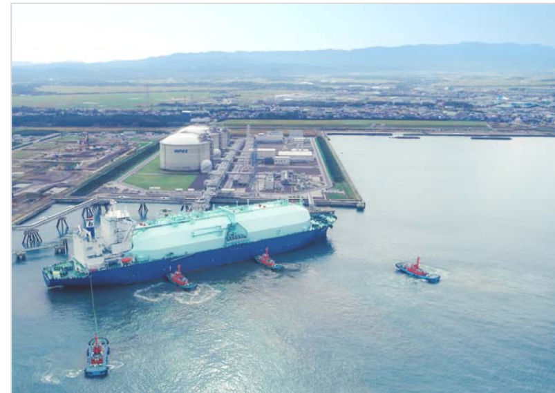
Naoetsu LNG Terminal
