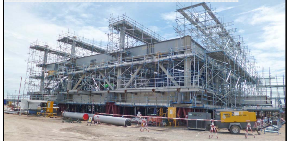
Fabrication of onshore LNG plant modules (Sep/2014, Thailand)
