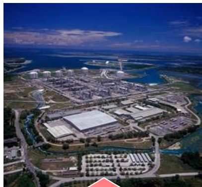
(Bontang LNG Plant)
