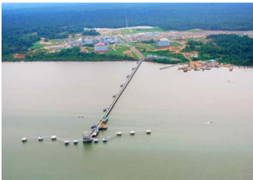
Tangguh LNG Plant
