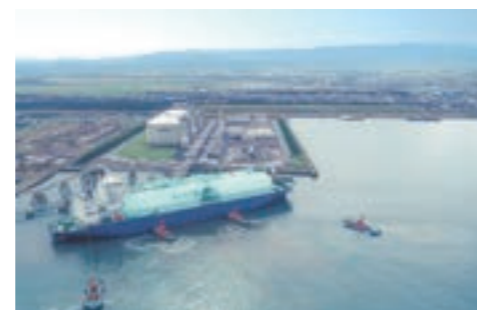
Naoetsu LNG Terminal
