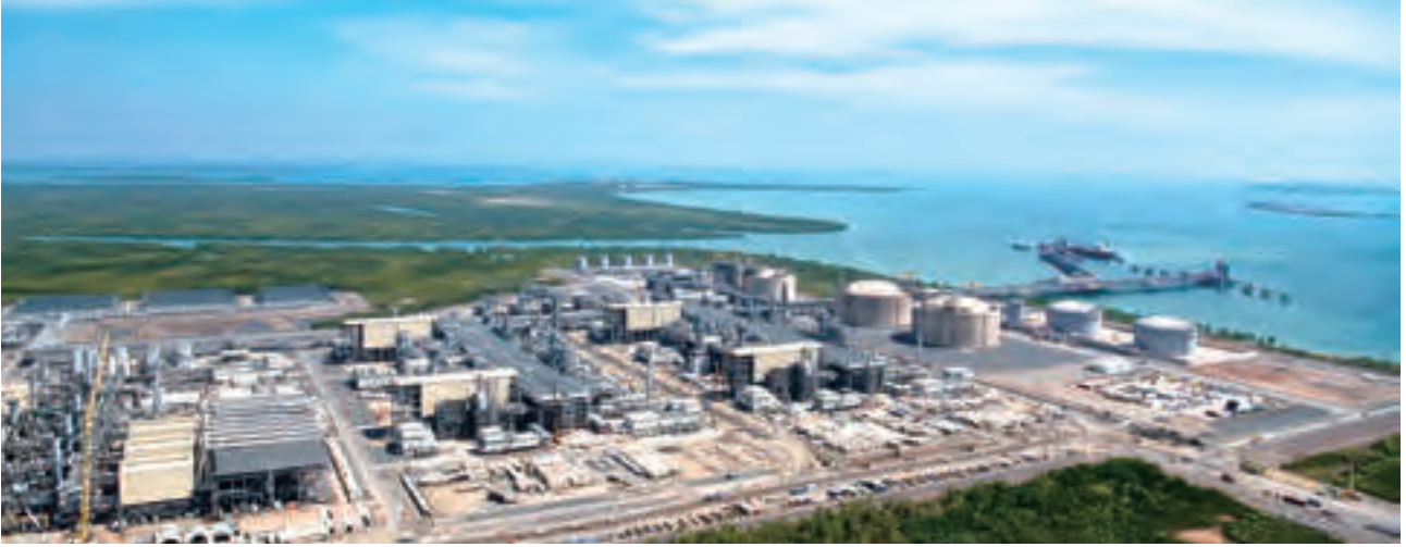
Onshore LNG plant
