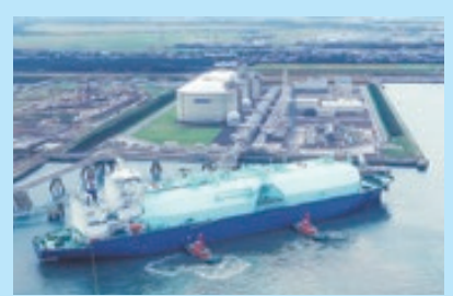
Naoetsu LNG Terminal
