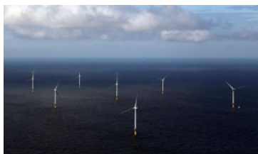
Luchterduinen offshore wind farm
