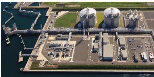
Naoetsu LNG Terminal
