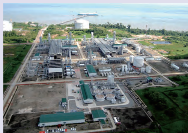
Train 1 and Train 2 at Tangguh LNG Terminal
