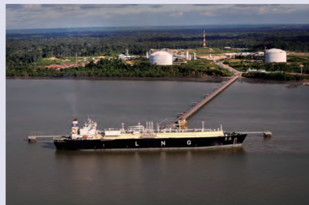
Unloading berth at Tangguh LNG Terminal
