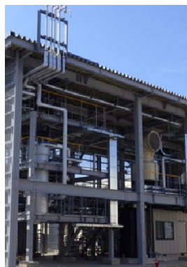
越路原プラント内の 実証設備
