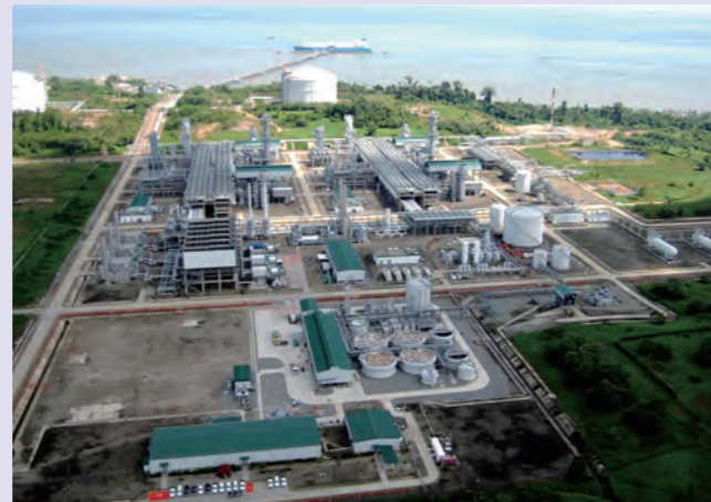
タンゲーLNG基地 第1及び第2液化系列
