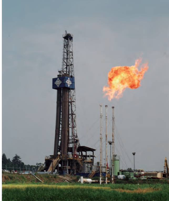
南長岡ガス田における試ガス
