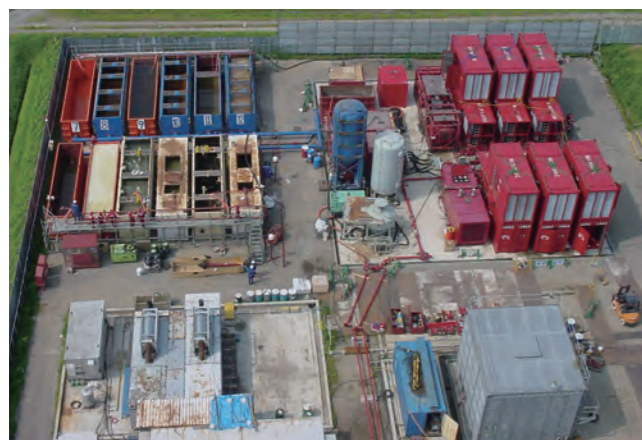
南長岡MHF-1作業現場
