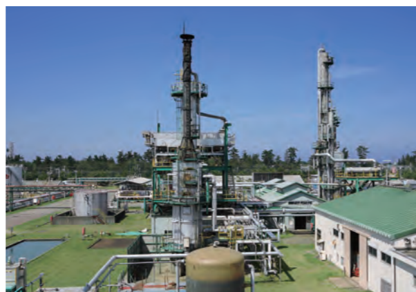
頸城原油の精製を目的に建設された帝石トッピング・プラント(株)
