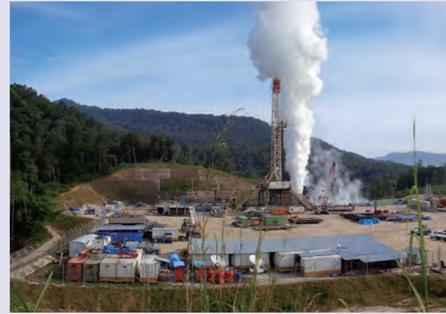
サルララ地熱発電プロジェクトの噴気試験
