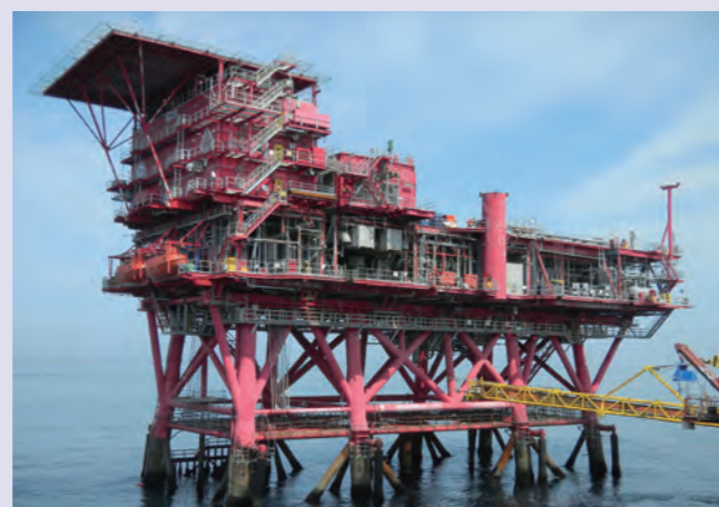
撤去作業中の磐城沖ガス田海洋プラットフォーム
