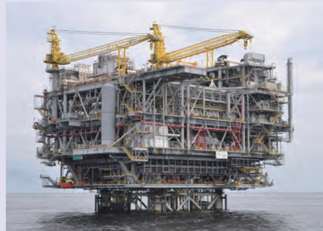
アンゴラ沖合ブロック14鉱区の生産施設
