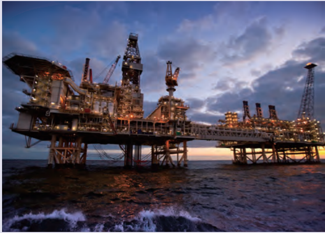
カスピ海ACG鉱区の生産施設
