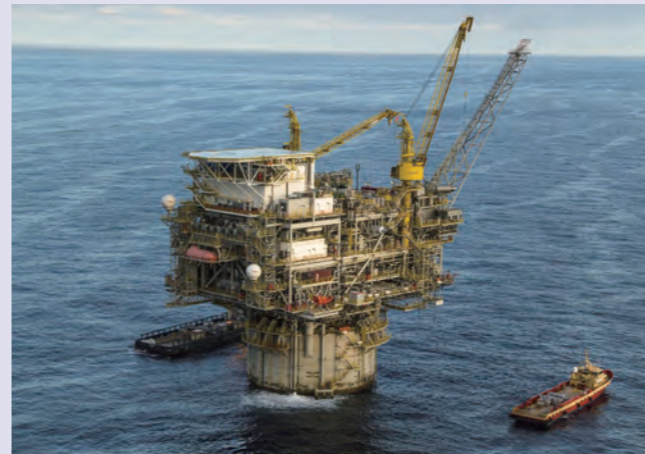
ルシウス油田の生産施設
