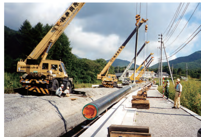
松本ライン建設工事
