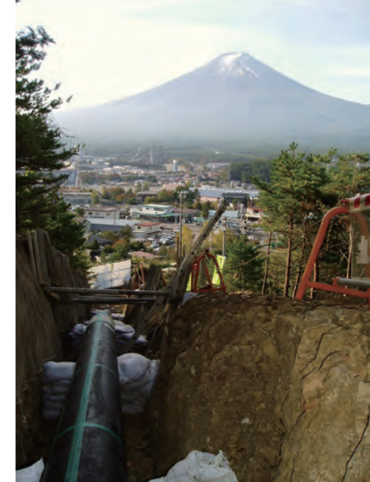
静岡ライン建設工事
