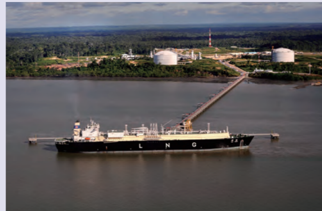
タンゲーLNG払出棧橋
