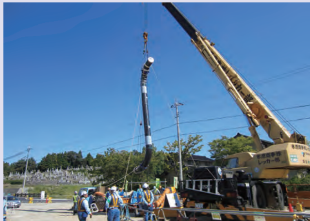
富山ライン建設工事
