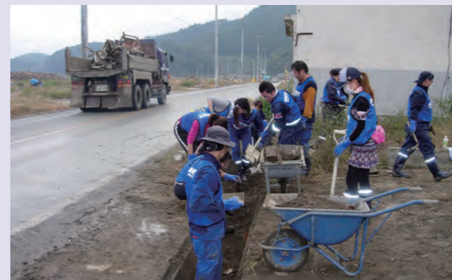
東日本大震災後の復旧支援活動(陸前高田市 2011年9月)
