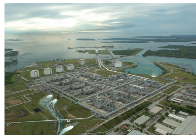
ボンタンLNG基地全景
