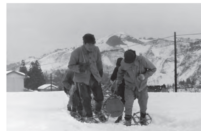
東京ラインの建設。雪の中人力でパイプを運ぶ
