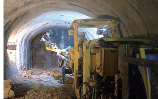
山岳トンネルの掘削 硬い岩盤や出水に阻まれながら山岳トンネル5本(総延長約12.6km)が掘削された
