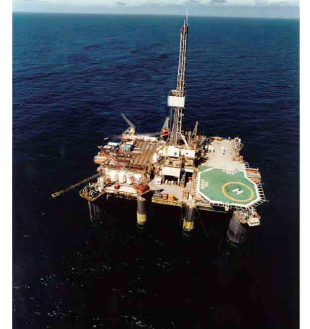
第1次掘削キャンペーンで試掘1号井(Dinichthys-1)を掘削中のSEDCO 703
