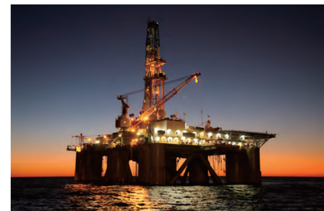
追加坑井を掘削してイクシス構造の詳細を確認
