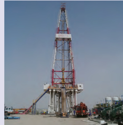
イラク・ブロック10鉦区における試掘井の掘削
