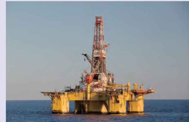
イクシスLNGプロジェクト、生産井の掘削開始
