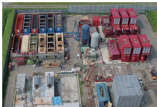
南長岡MHF-1作業現場
