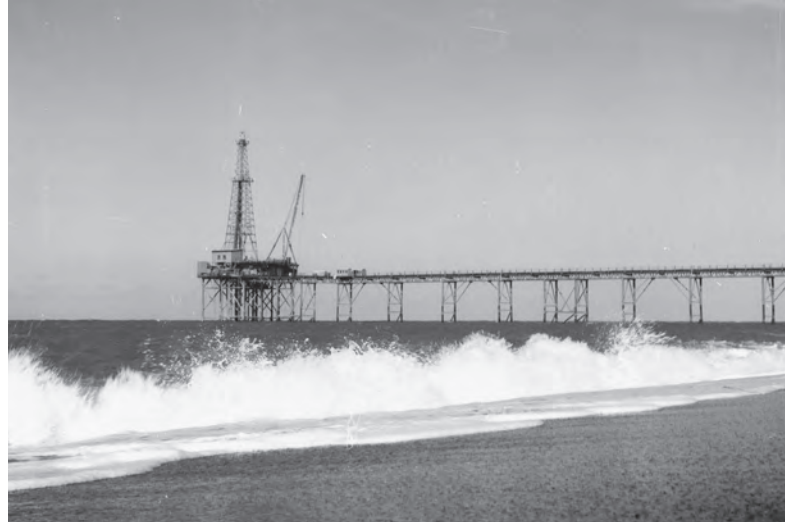
頸城油・ガス田の生産施設(第一人工島)
