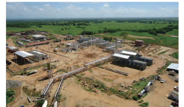
ベネズエラのコバマコヤ・ガスプラント
