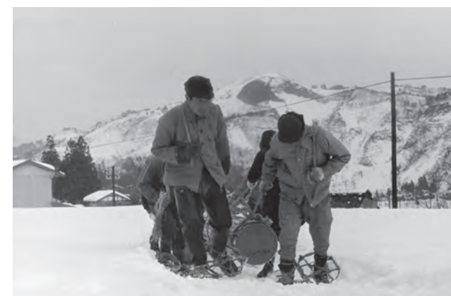
東京ラインの建設。雪の中人力でパイプを運ぶ
