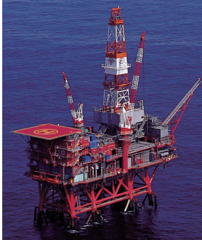
磐城沖ガス田 福島県双葉郡楡葉町沖合40km(水深154m)に建設した海洋プラットフォーム
