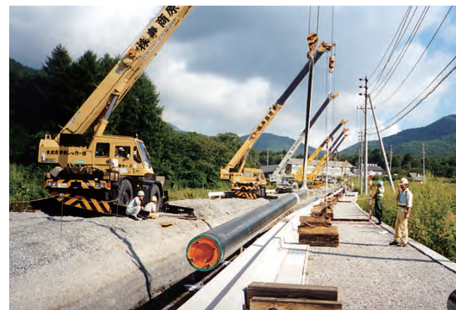
松本ライン建設工事
