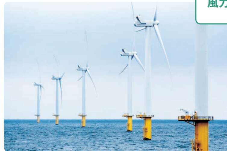
ルフトダウネン洋上風力発電所
